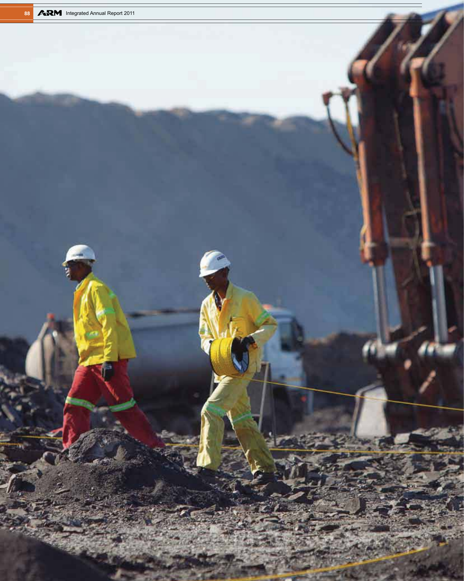
Goedgevonden Coal Mine blast preparation
