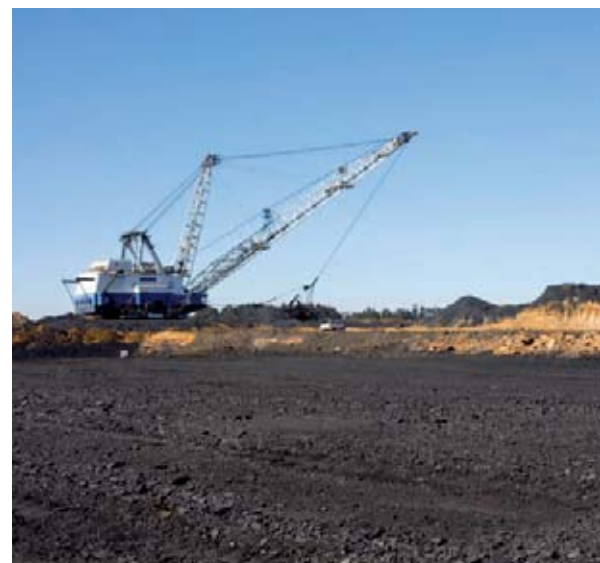
Overburden removal at Goedgevonden
